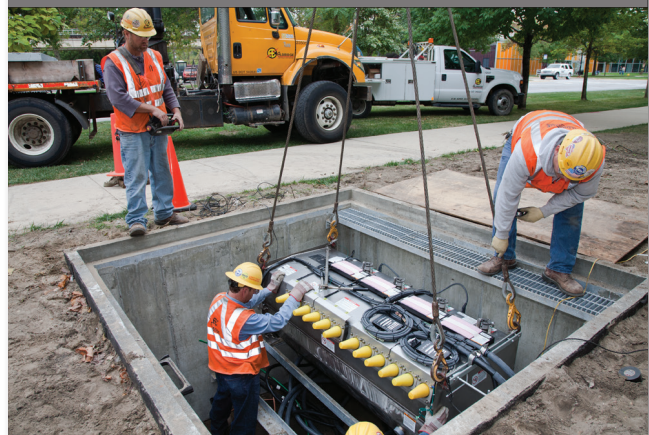
Instalación de un Seccionador de Distribución Subterránea Vista Estilo Sumergible™ de S&C.
